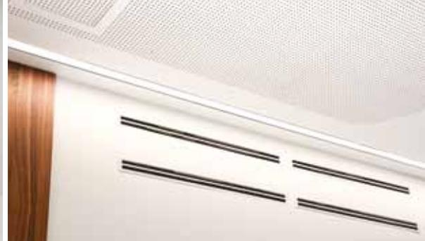
**DETAILREICH.** Besonders in den Eck- und Randbereichen ist die Detailarbeit des Trockenbaus gut zu erkennen. Verdeckte Lichtleisten, Klimaanlage, die Verbindung mit Gipskarton- zu Metalldecken, brandschutzverkleidete Betonträger – all das auf wenigen Quadratmetern zusammengefasst.
